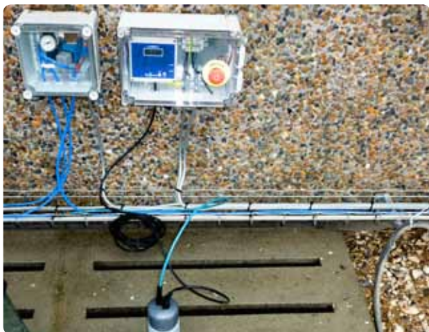
Billede 4. PH-værdi aflæses ved procestanken.
